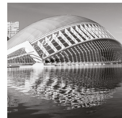
L' Hemisfèric Valencia Sanitago Calatrava
